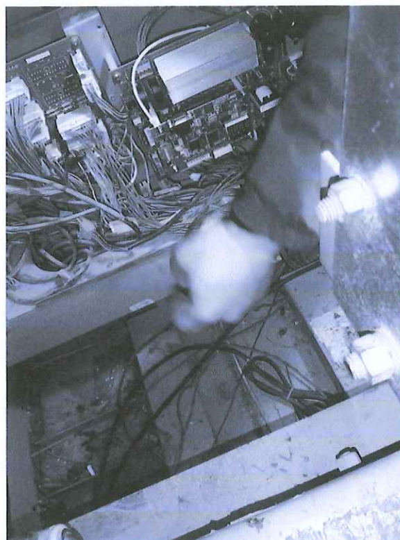
门机板更换后
