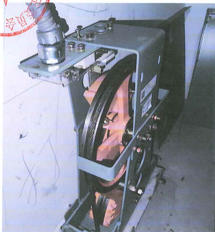
限速器更换后
