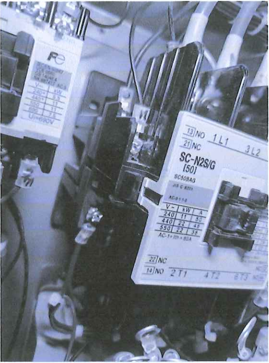
主接触器更换后
