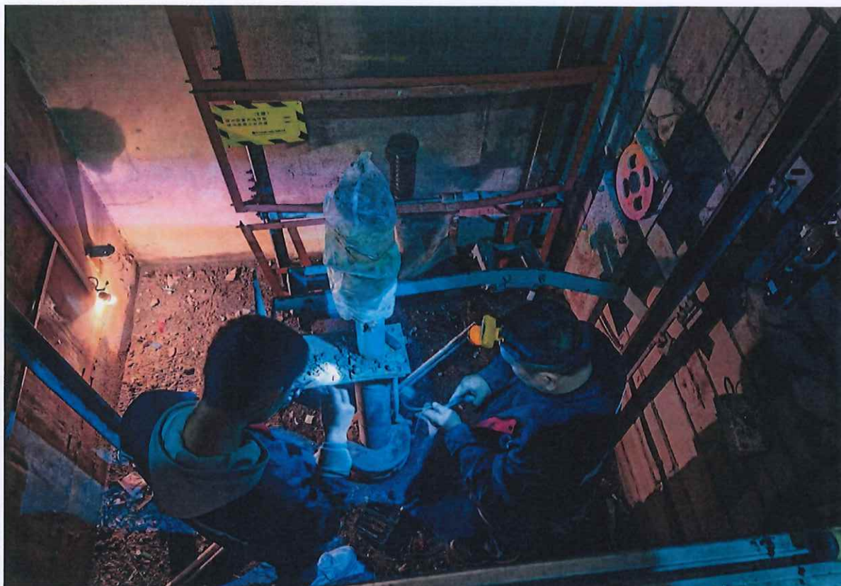
补偿缆断裂更换中：
