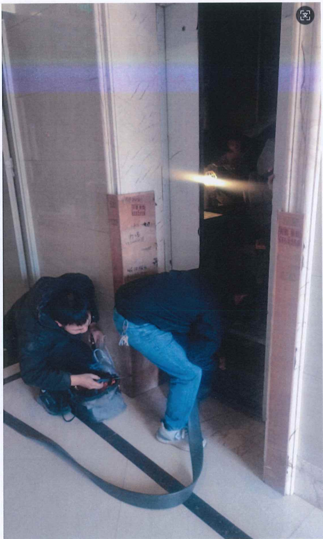
补偿缆断裂更换中：
