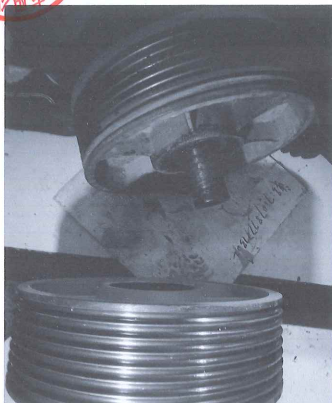
轿顶反绳轮更换中
