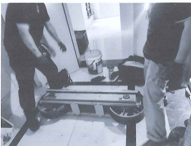
轿顶反绳轮更换中
