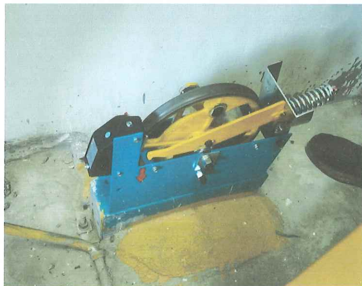
限速器更换后
