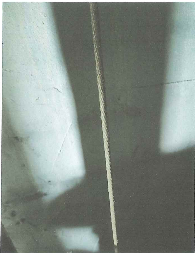
限速器钢丝绳更换前
