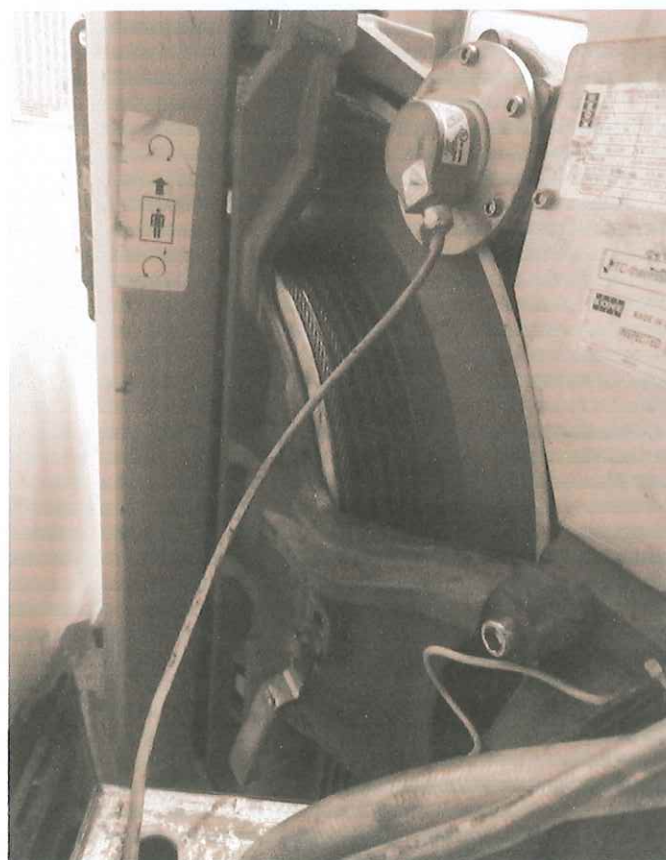
曳引轮更换后
