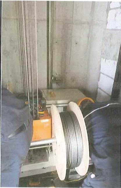
电梯曳引钢丝绳更换中
