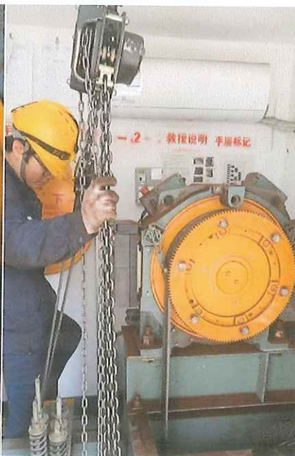
电梯曳引轮更换中
