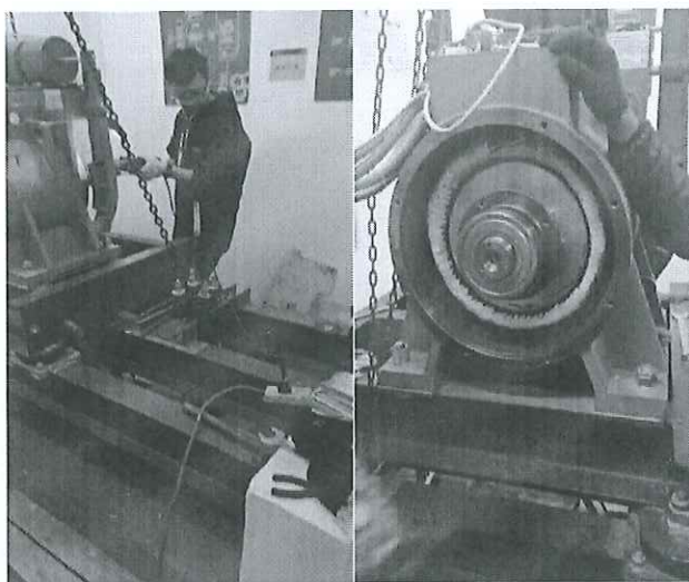
曳引机调心滚子轴承、深沟球轴承更换中
