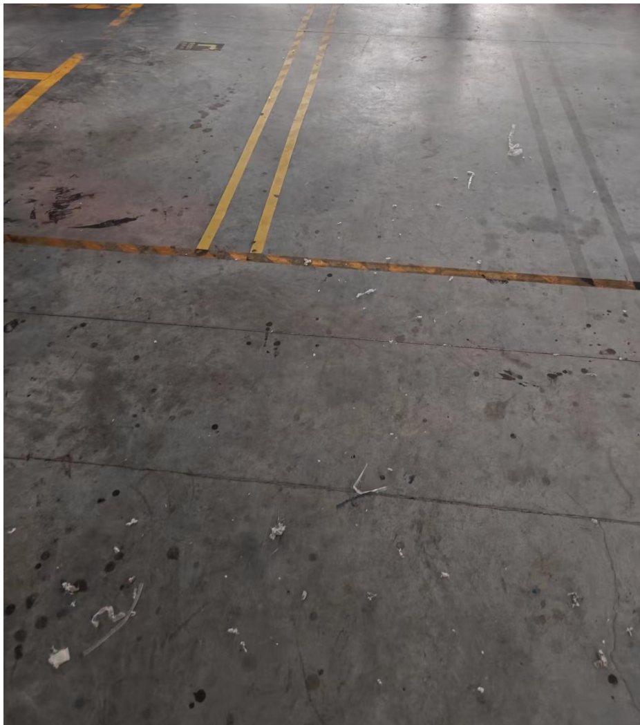
图 3-4 本项目车间硬化照片
